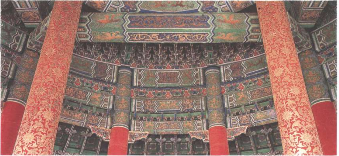
O interior do teto do Qiniandian (Saguão de Preces pela Boa Colheita), na extremidade norte do complexo do Templo do Céu, em Pequim. Neste saguão o imperador, em sua posição de representante do céu na terra, oferecia preces por boas colheitas.
