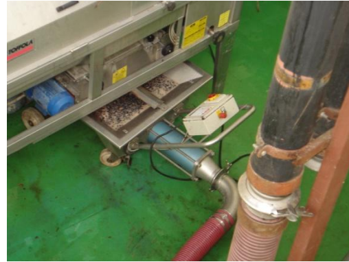
Fig.12-Transfega do mosto para a cuba
