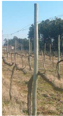
Poste de Madeira
